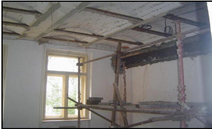
Obrázek 1 Odborné učebny před rekonstrukcí – srpen 2010
